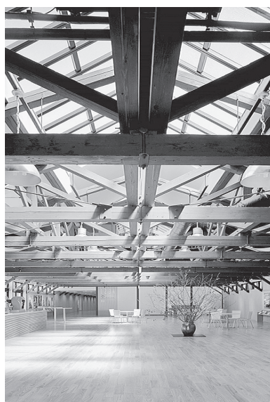
かつての絹織物工場の木造構造を活かした再生 (撮影：小川泰祐)
