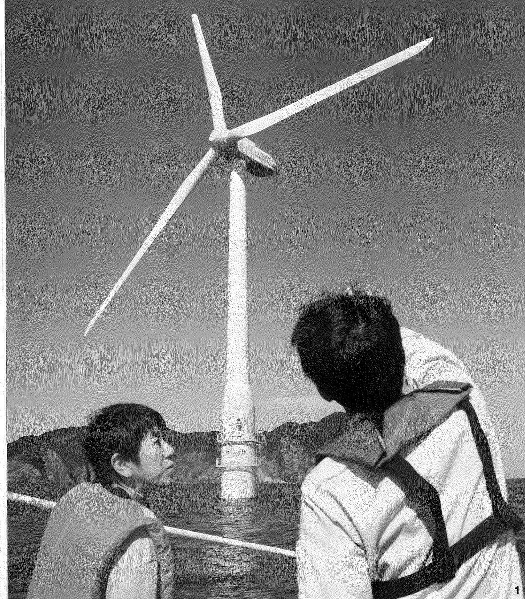
1/野又政宏さんと五島列島の杵島の2キロ沖に浮いている風力発電を見に行く。発電した電力は海底ケーブルで変電所へ運ぶ。 2/風力発電の余剰電力で水素を製造。トルエンに混ぜて液体化すれば、運んだり貯蔵したりが容易にできる。
